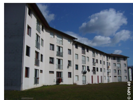
Bâtiments à rénover de l'îlot La Pince (Saint-Paul-lès-Dax)
