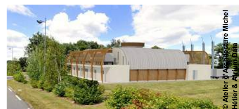
Vue extérieure générale du data-centre démonstrateur
