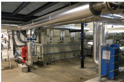
Installation pilote de récupération de l'énergie thermique de fumées d'une chaufferie Biomasse à Creil
