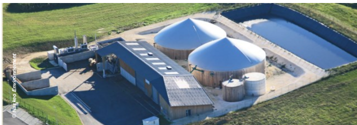
Installation de méthanisation de Naskeo
