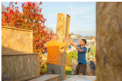
Pose d'un élément BLOKIWOOD
