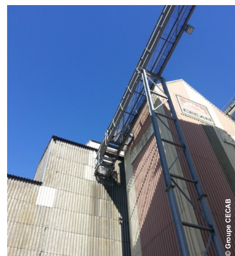
Séchoir à grain implanté dans un silo de stockage
