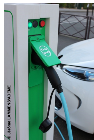
Recharge d'un véhicule électrique
