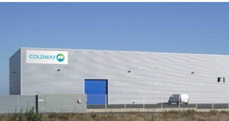
Les installations COLDWAY à Pia
