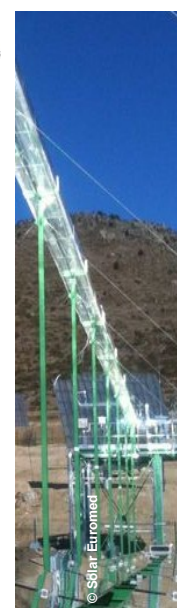
Champ solaire thermodynamique à miroirs de Fresnel
